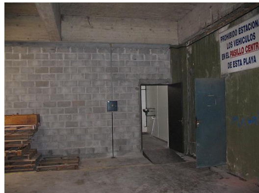
Vista entrada interna
